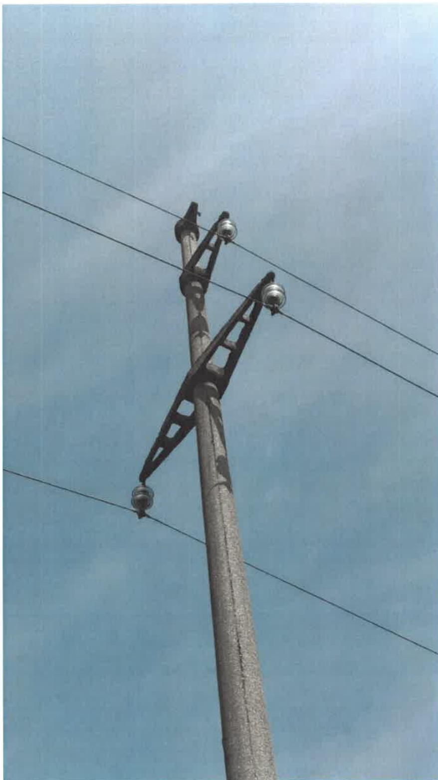
Stalp nr. 9. Echipare – Lant de izolatoare simplu, izolatie sticla
