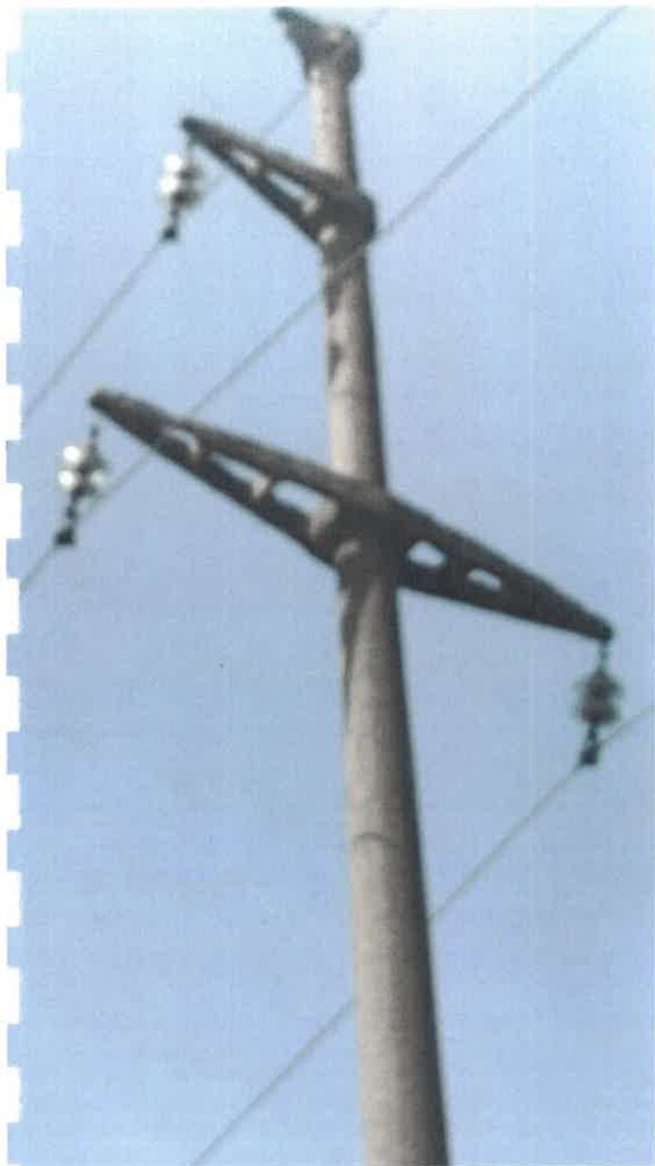
Stalp nr. 4. Echipare – Lant de izolatoare simplu, izolatie sticla
