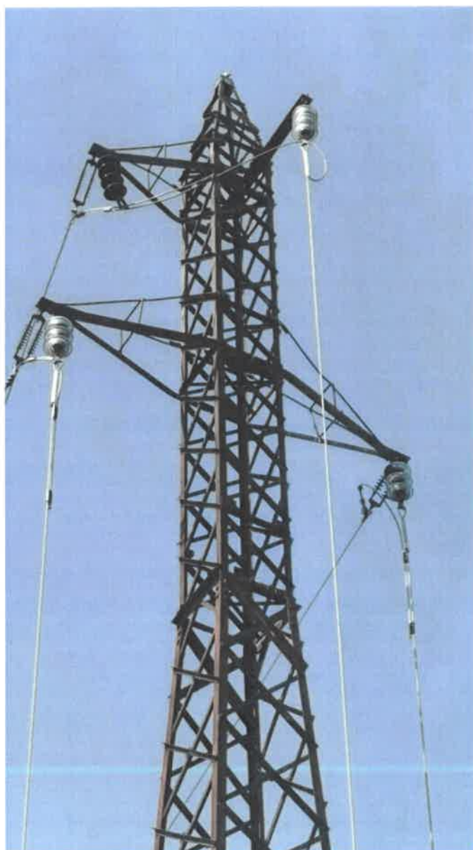
Stalp nr. 1. Echipare – Lant de izolatoare dublu, izolatie compozita
