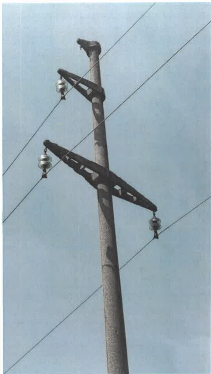
Stalp nr. 6. Echipare – Lant de izolatoare simplu, izolatie sticla
