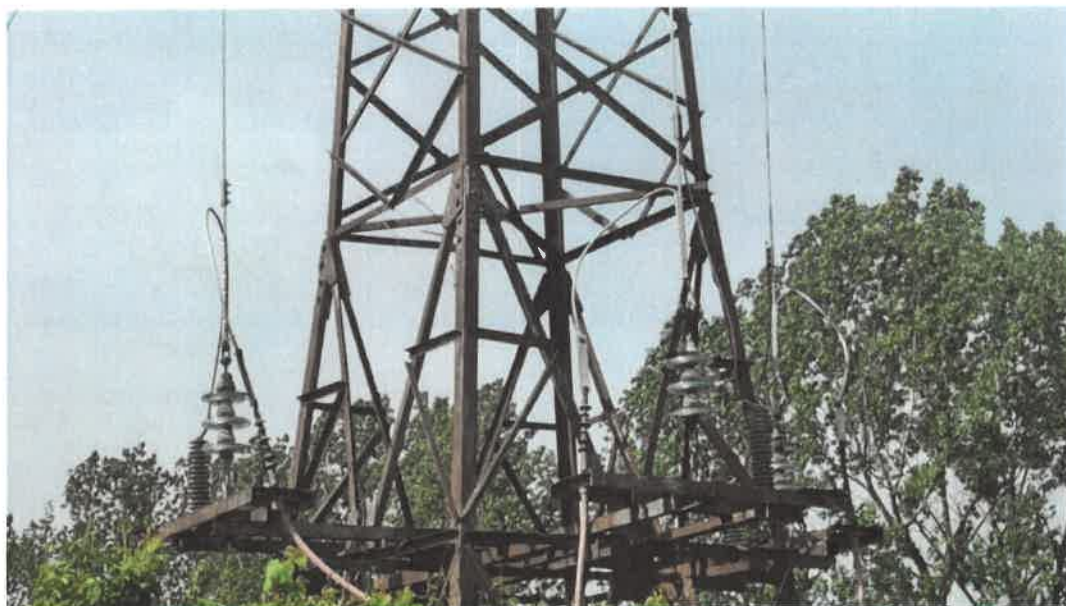
Stalp nr. 1. Echipare – Lant de izolatoare dublu, izolatie compozita
