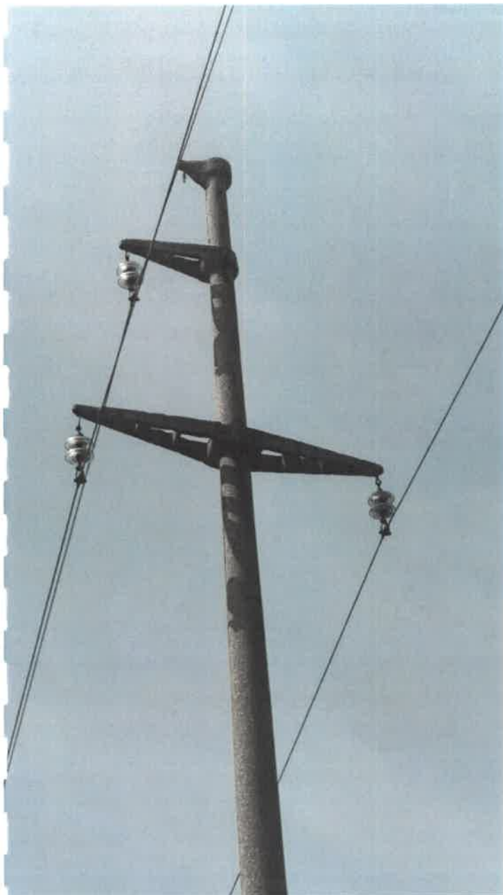
Stalp nr. 8. Echipare – Lant de izolatoare simplu, izolatie sticla
